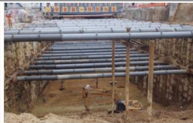
坑底设置排水盲沟（图示是明沟开挖阶段）
