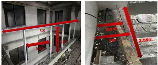
图 4 9 层护栏及设备平台尺寸图
