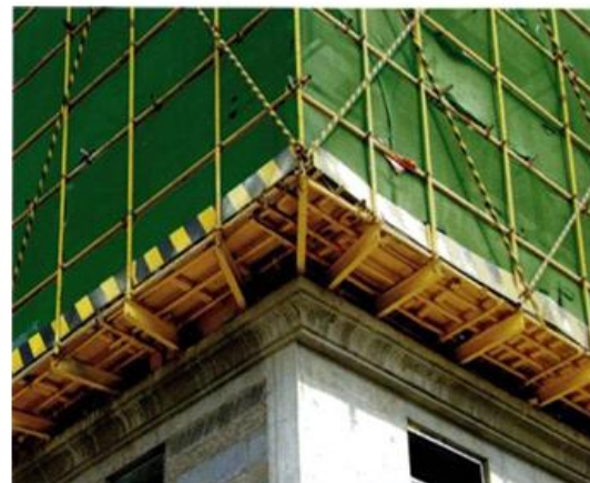
二、悬挑式钢管外脚手架
