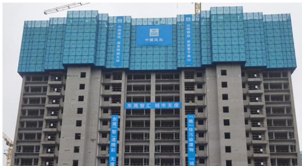
五、附着式提升钢脚手架（适用于高层）
