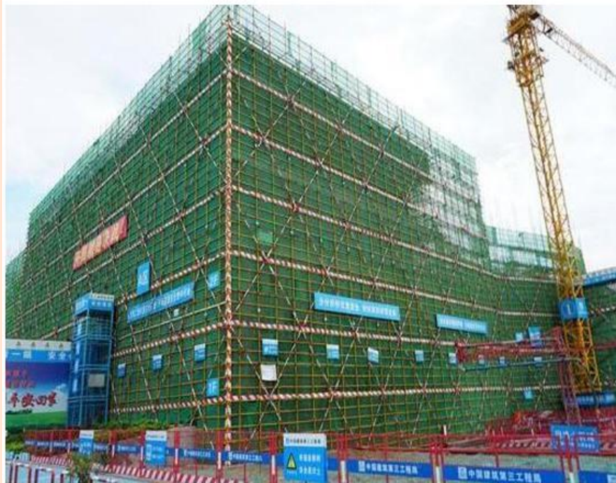
一、落地式钢管外脚手架
