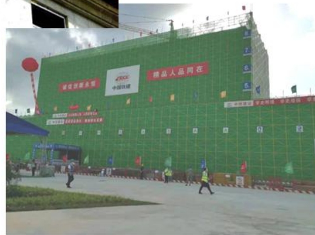
三、落地式钢管外脚手架（钢网）
