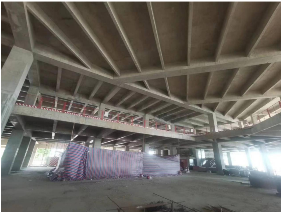
施工现场照片
