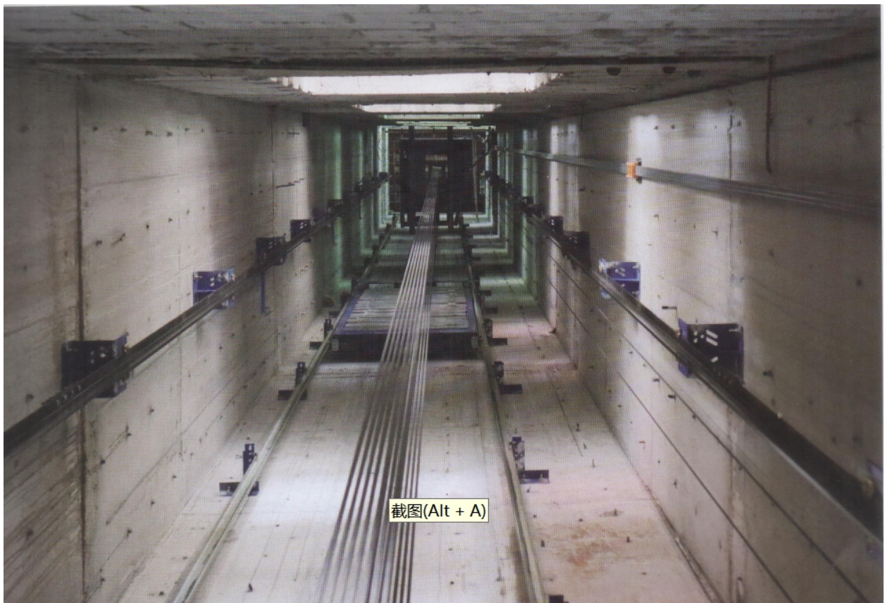
施工升降机电梯井道构造图片
