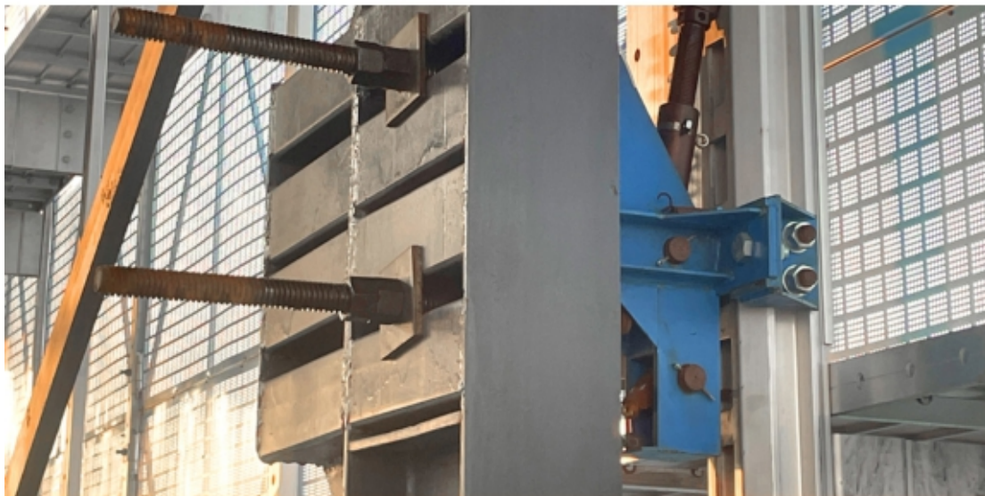
支顶器、附墙支座、穿墙螺杆
