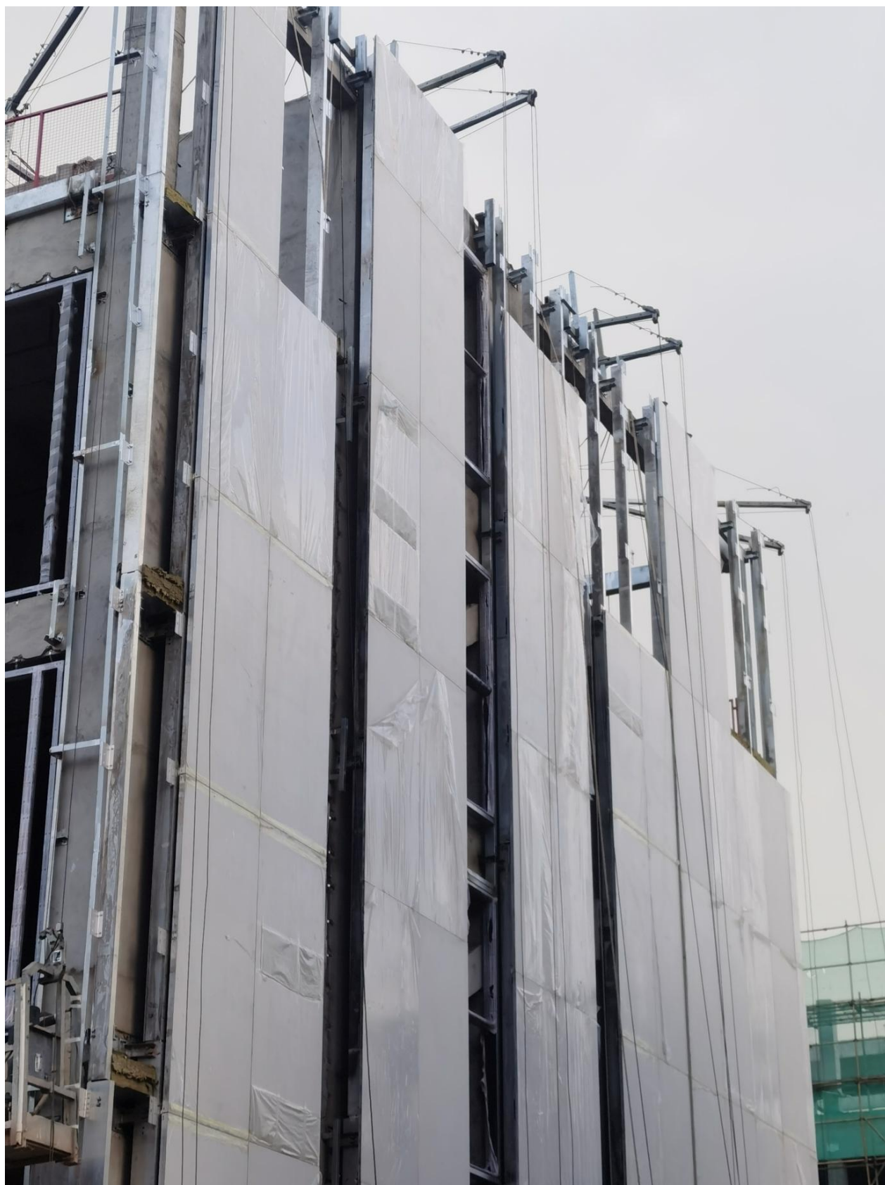
岩板幕墙现场图片
