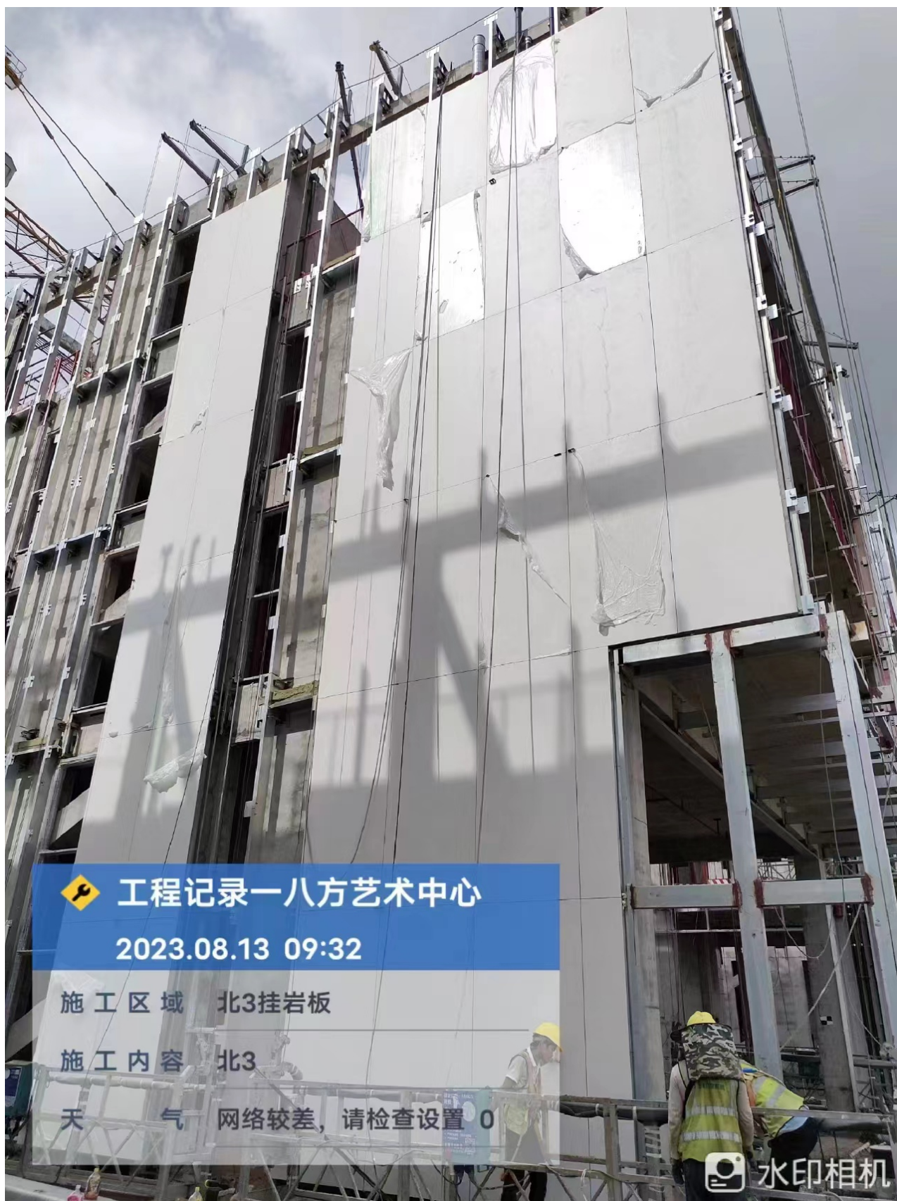
岩板幕墙现场图片
